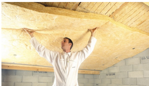
©Isover - Isolation des combles
