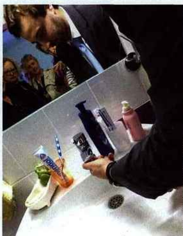
L'installation d'un aérateur hydro-économique est très rapide.
