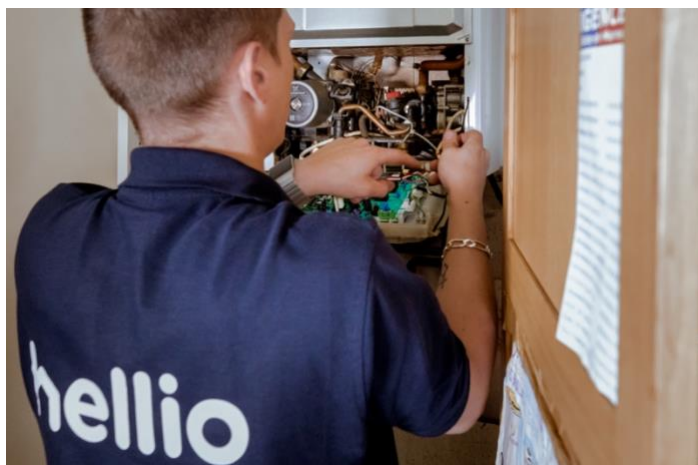
Pose de la chaudière gaz à condensation chez un particulier par un professionnel Hellio.
